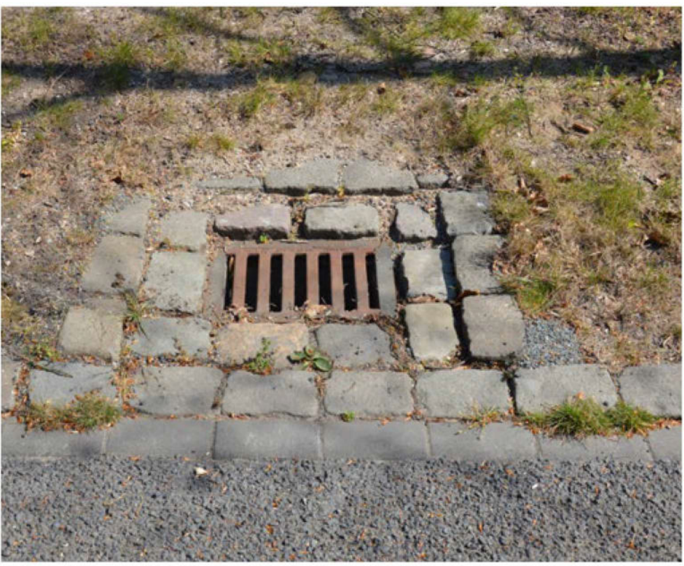
Kolken zijn onderdeel van de wegrand en worden omsloten door melafierkeien (natuursteen)
