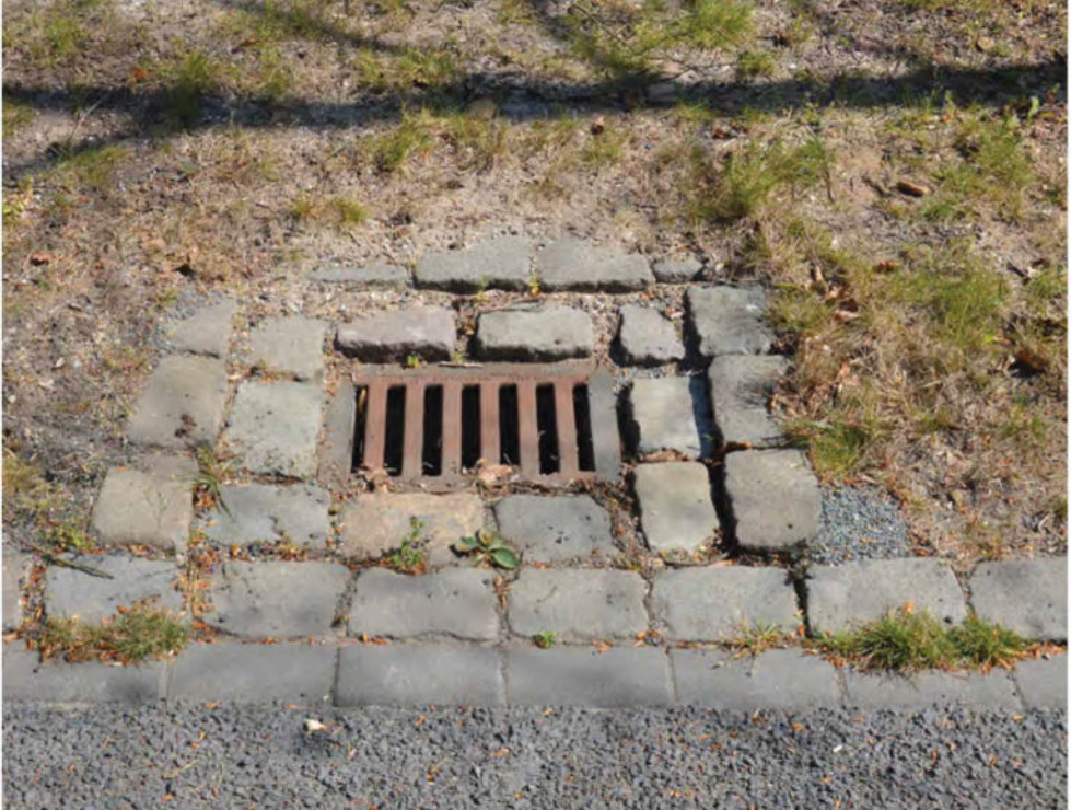
Kolken zijn onderdeel van de wegrand en worden omsloten door melafierkeien (natuursteen)
