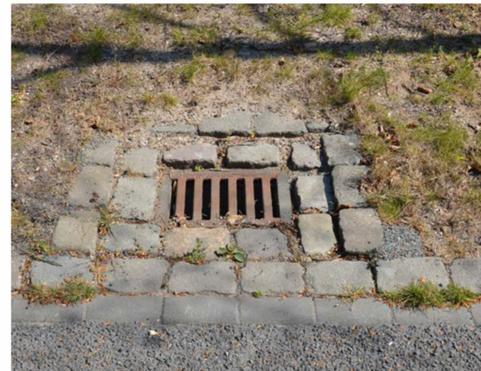
Kolken zijn onderdeel van de wegrand en worden omsloten door melafierkeien (natuursteen)
