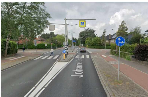
Figuur 3.7 Locatie Johannes Geradtsweg 2
